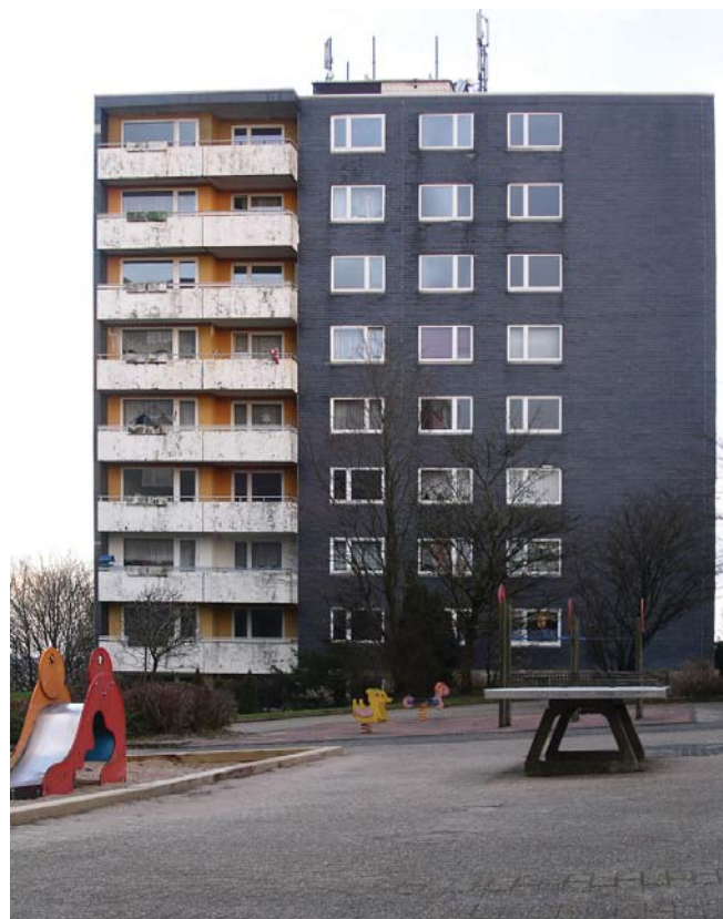
(Eines der maroden Hochhäuser im Rehsiepen an der Straße Morbennsfeld)
